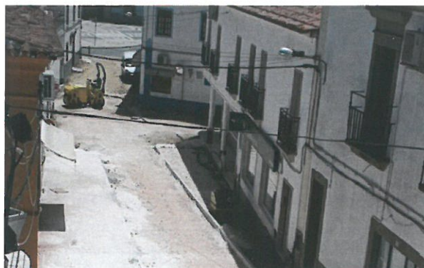
Obras de Reabilitação Urbana da Vila de Redondo – Zona C – 2ª Fase
