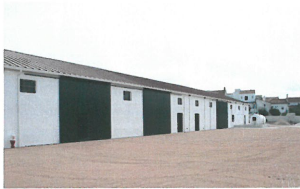
Obra do novo Estaleiro Municipal em fase de conclusão
